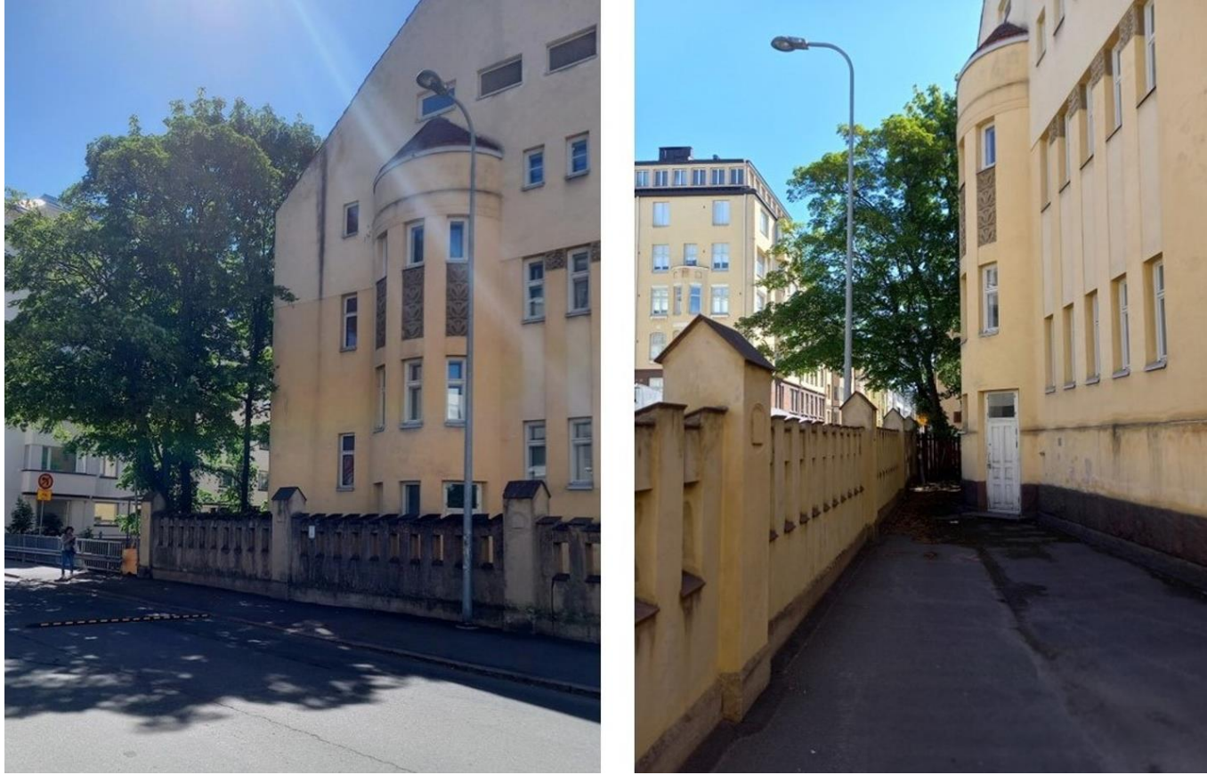
Kuva 69 Marian sairaalan aluetta Lapinlahdenkadun varrella rajaava rapattu tiilimuuri puretaan rakentamisen ajaksi ja rakennetaan uudelleen alkuperäisen toteutuksen mukaisesti. Baanan reunalla oleva vanha vaahtera joudutaan kaatamaan (Ramboll Finland Oy).
