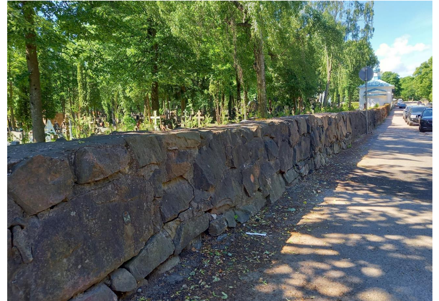
Kuva 68 Ortodoksisen hautausmaan 1800-luvulla rakennettu kivimuuria joudutaan purkamaan ja ennallistamaan Mechelininkadun ja Profeetta Elian kappelin väliseltä osuudelta (Ramboll Finland Oy)
