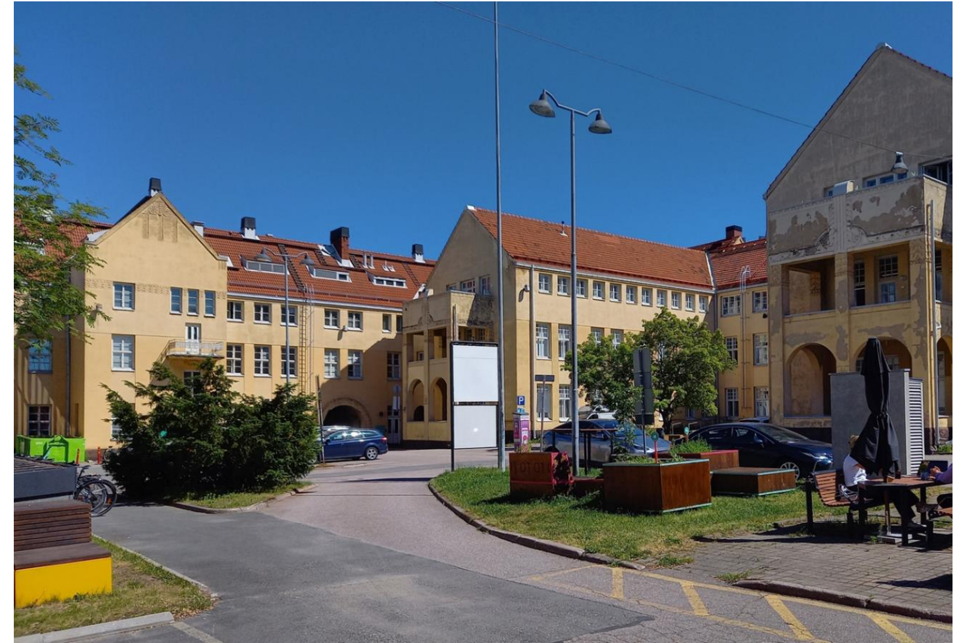
Kuva 13 Marian sairaalan vuonna 1909 valmistuneet, arkkitehti Lars Sonckin suunnittelemat hallintorakennus ja sisätautipaviljonki ovat suojeltuja
