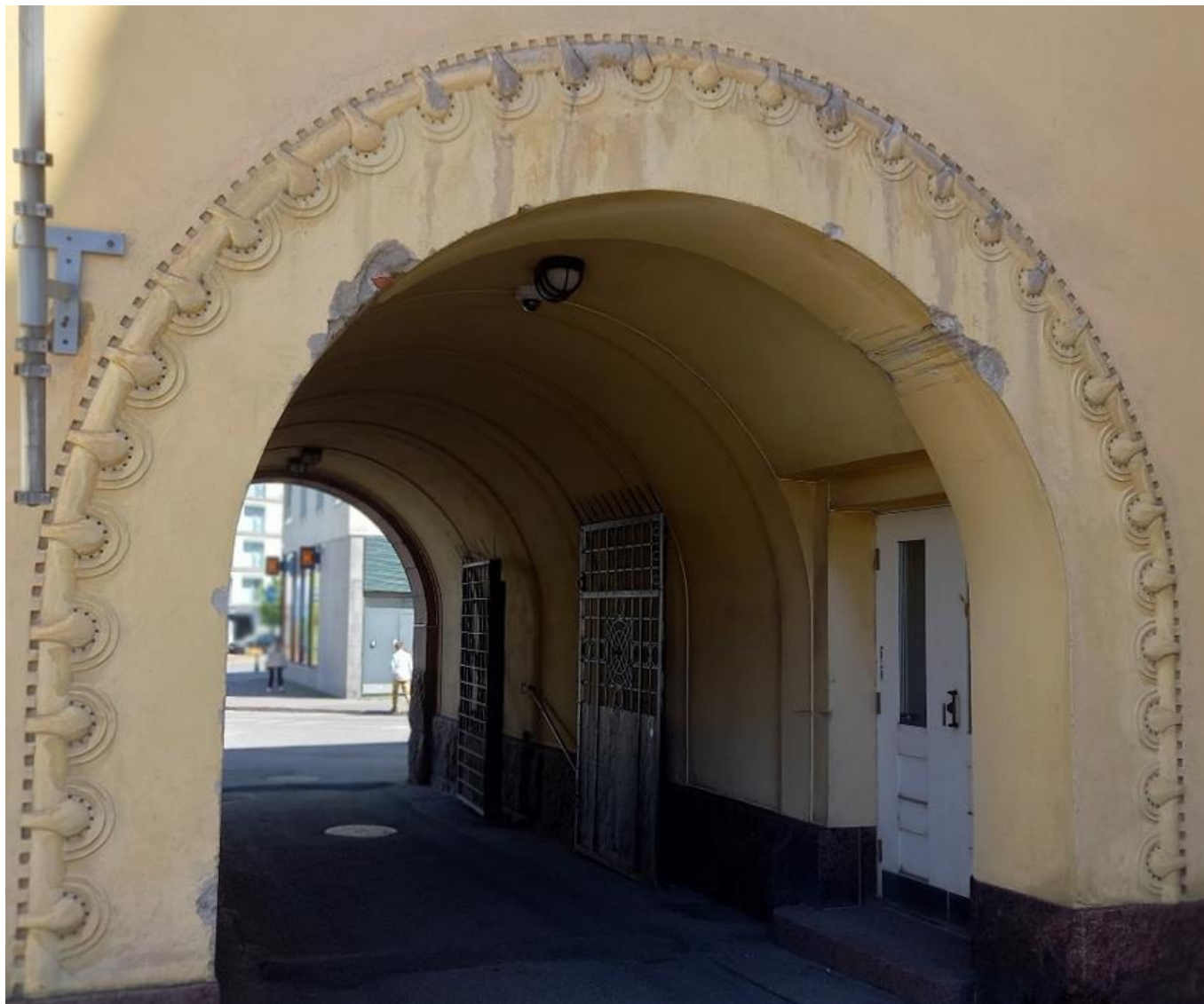
Kuva 67 Rakennusten rappauksissa on jo valmiiksi jonkin verran vaurioita. Rappausten ja rappauskoristeiden kunto tulee kartoittaa ennen louhintatöiden aloittamista (Ramboll Finland Oy)
