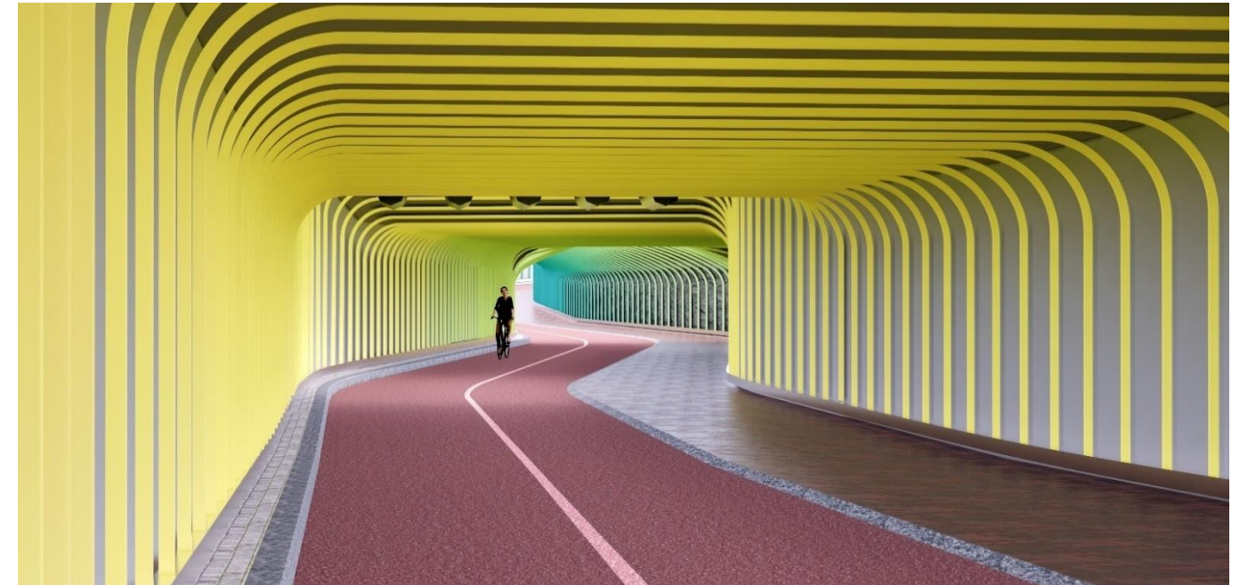
Kuva 43. Näkymä itään. Tunnelijaksolla profiilien väri on toteutettu liukumavärein. Tunnelijaksolla olevat puhaltimet ovat nostettu syvennyksiin tunnelin katossa.
