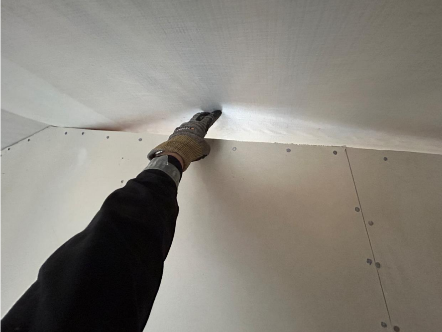
Kuva 1. Huoneistojen välisen seinän ja vesikaton liitos ei ole tiivis. Savu ja tuli leviää helposti naapurin puoleiselle ullakolle. Kuva: Juhan-Petteri Laakso / SPPL.
