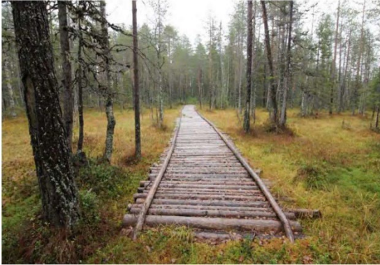
Kuva 23. Viita-ahon ja Huotarinhaudanahon toisistaan erottavan suon ylittävä uusi kapulasilta.
