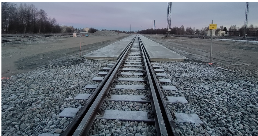
Kuva 14. Nelikiskoratkaisu sähköistämättömällä rataosuudella Torniossa.
