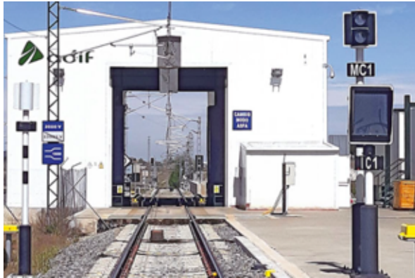
Kuva 13. Raideleveydenvaihtolaite, jossa liikkuvan yksikön telien/pyöräkertojen raideleveys muuttuu ja sama yksikkö voi liikkua useammalla raideleveydellä. Pyörät siirtyvät akselilla ja lukittuvat haluttuun leveyteen. (Adif)
