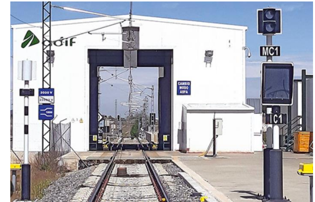
Raidelevyden vaihtolaite (Adif)
